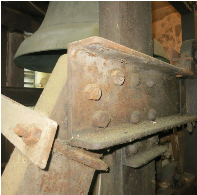
Genieteteter Rahmen und geschraubte Strebe
